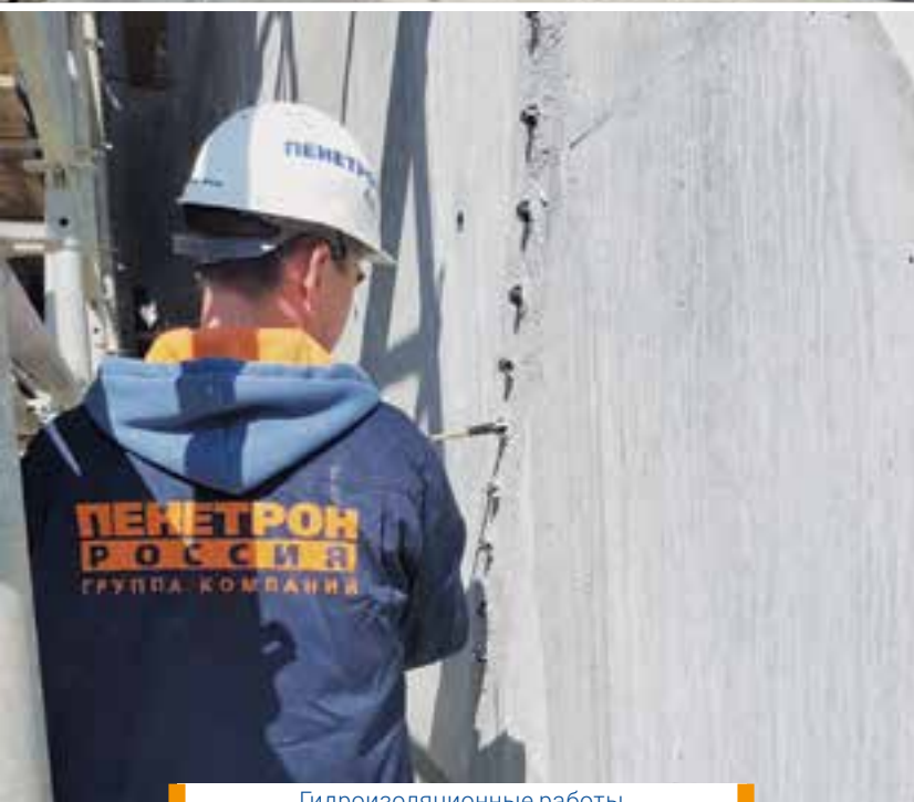
Гидроизоляционные работы на строительстве сухого дока ССК «Звезда»
